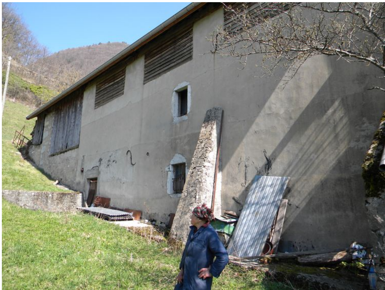
Vue de la façade arrière.
