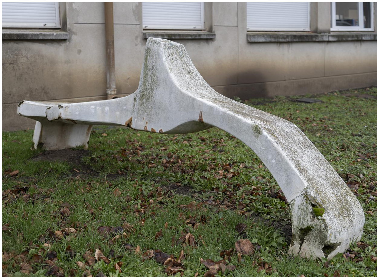
Détail d'un élément
