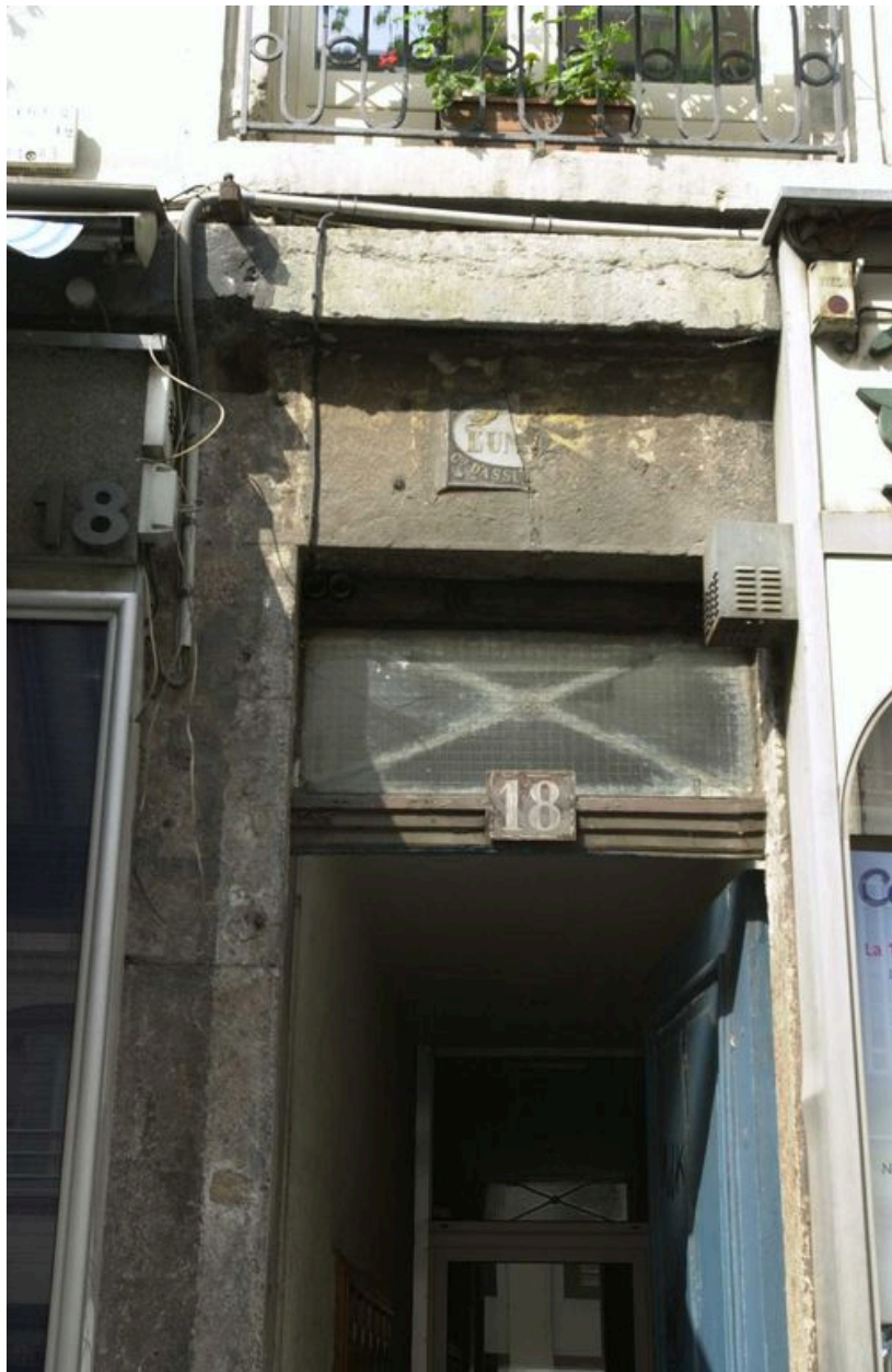
Porte d'entrée : ancienne plaque d'assurance
