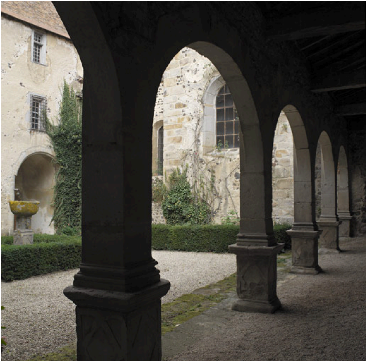
Vue intérieure de la galerie située devant l'aile est, depuis le sud-est.
