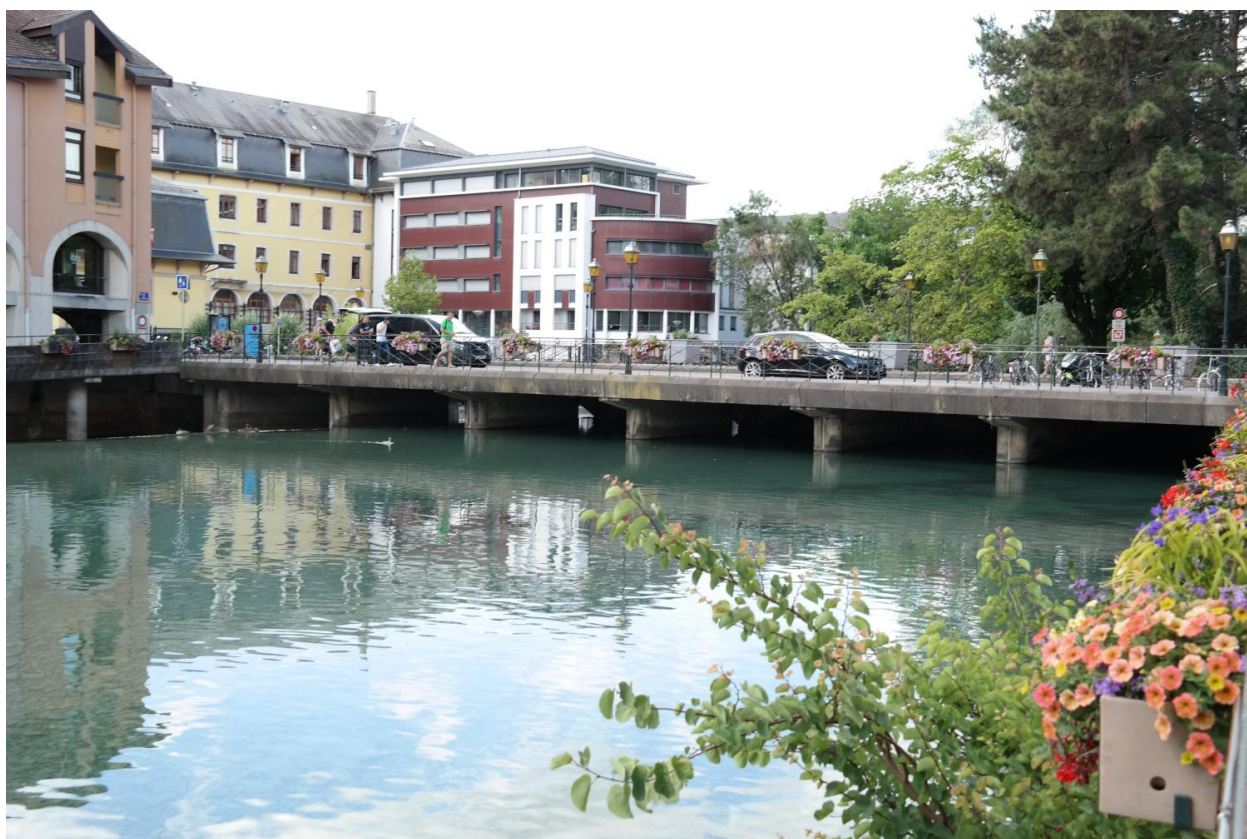
Pont rue de la gare, vue de la face amont
