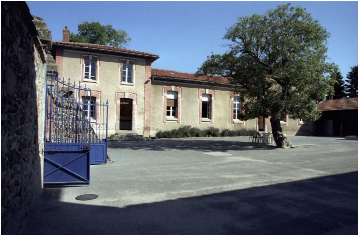
Bâtiment nord (filles), façade antérieure vue depuis la cour.
