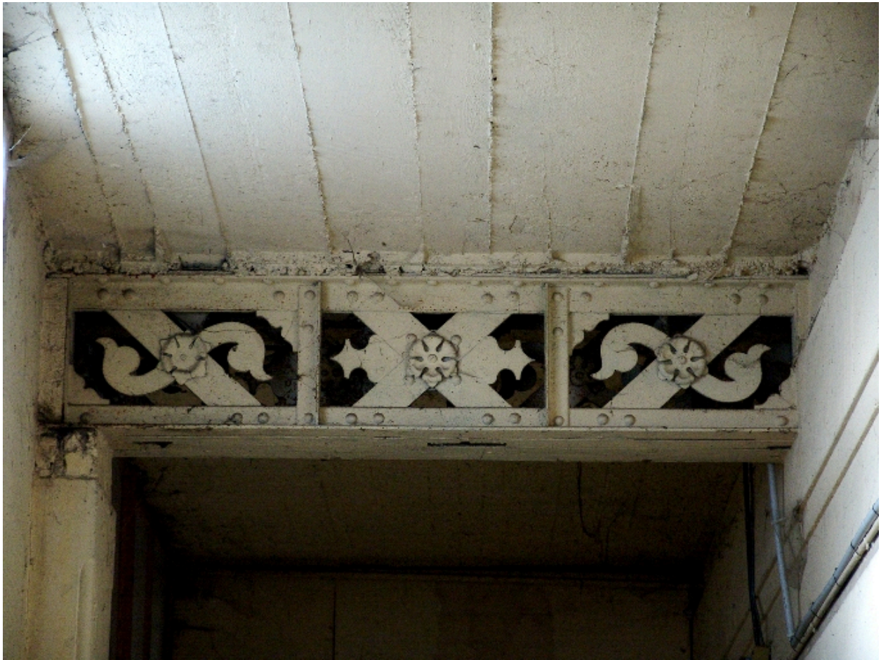
Traverse métallique d'un couloir du 1er étage de soubassement
