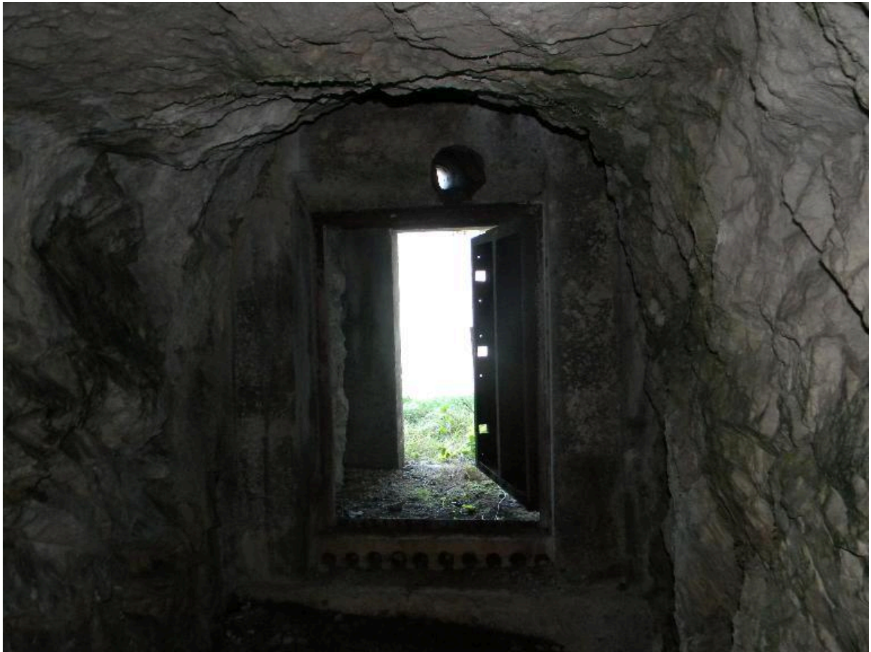
Vue de l'entrée de la galerie de la Poudrière depuis l'intérieur.
