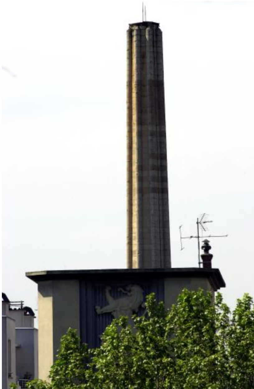
Vue de la cheminée de la chaudière
