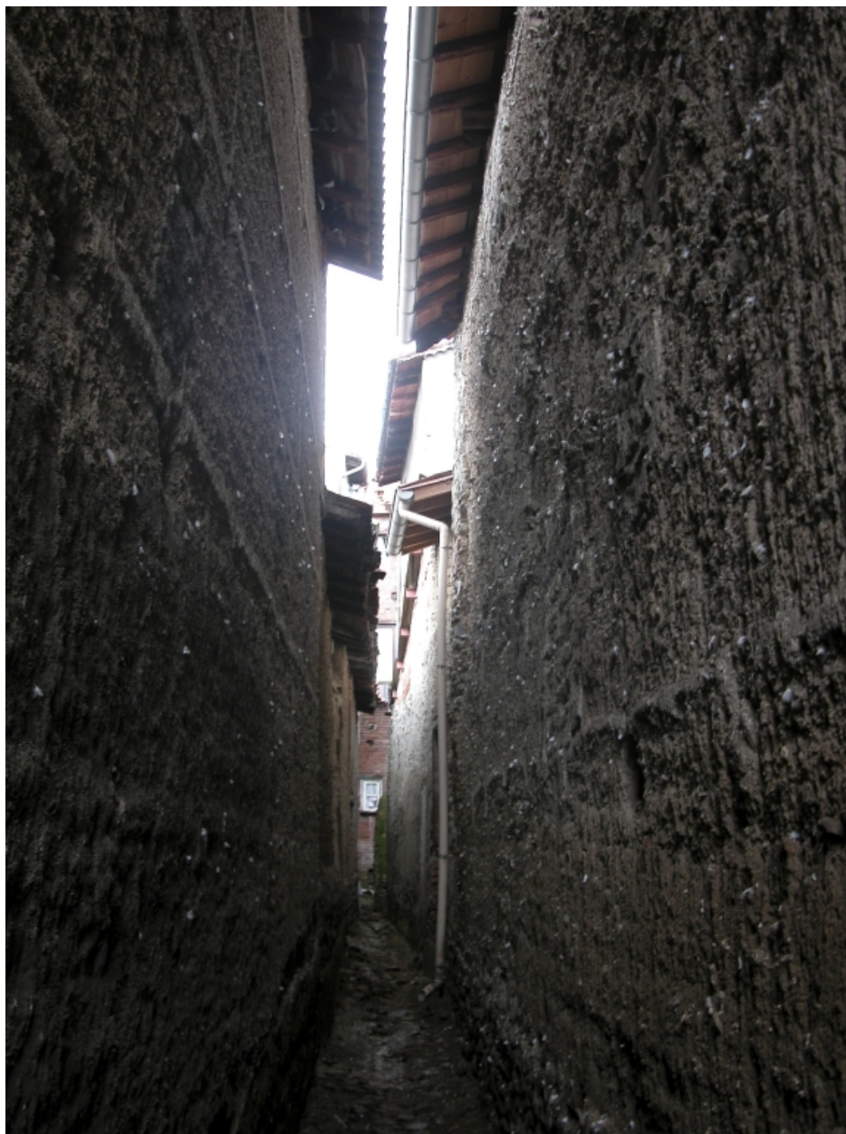
Îlot 2. Saint-Jean (rue) 32, 34. Vue générale de la traversière entre les deux maisons.
