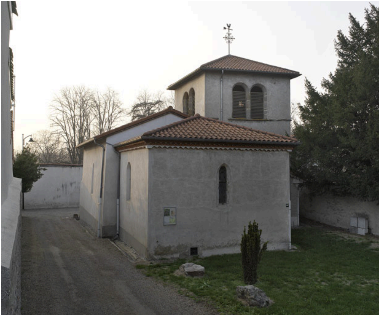
Vue d'ensemble de l'église depuis l'est.
