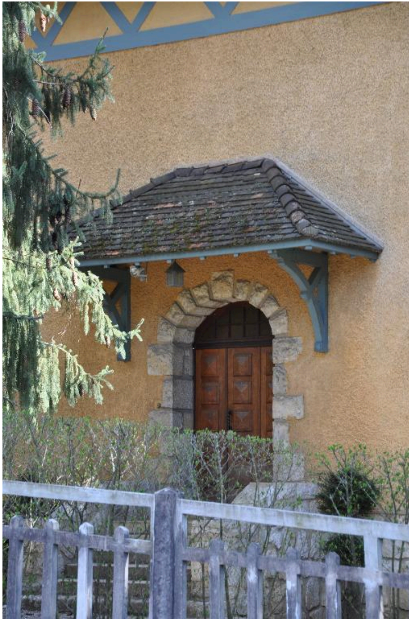
Vue de la porte d'entrée sur l'élévation nord
