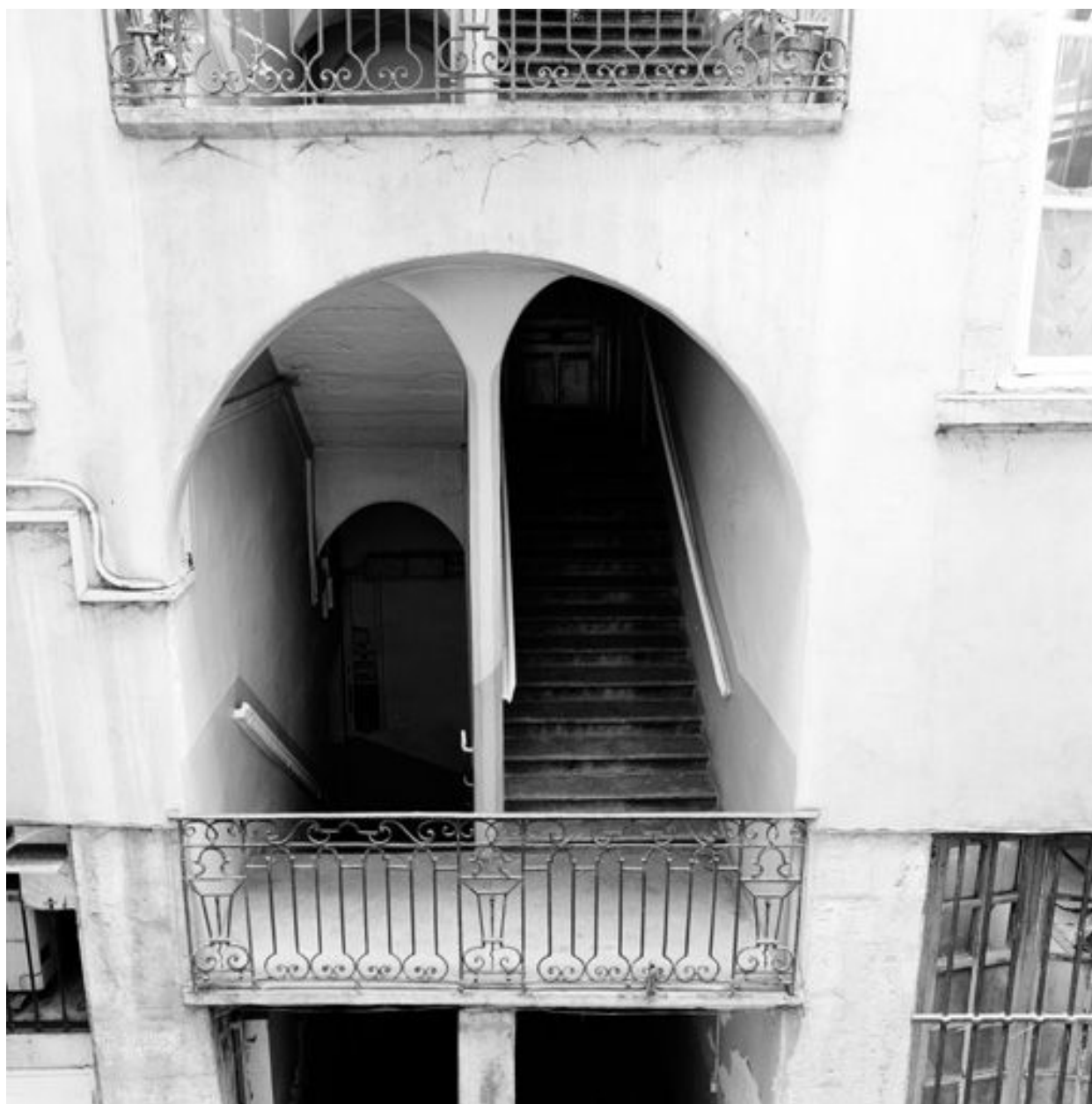
Cour, 1er bâtiment, rez-de-chaussée de l'escalier
