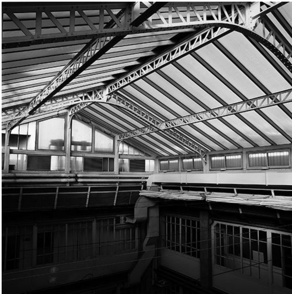
Toiture en verrière de l'espace au-dessus du hall
