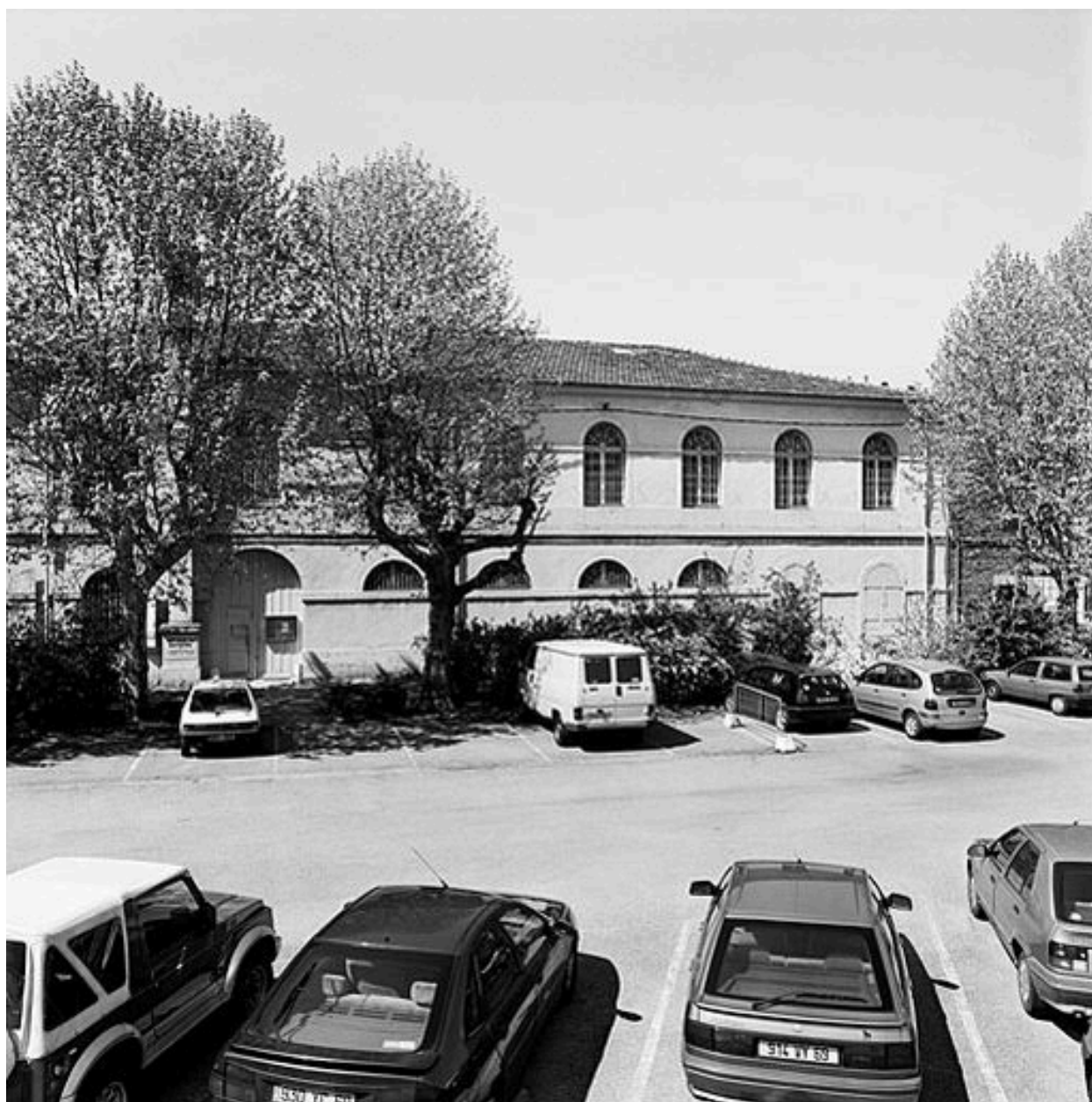
Bâtiment de stockage: façade
