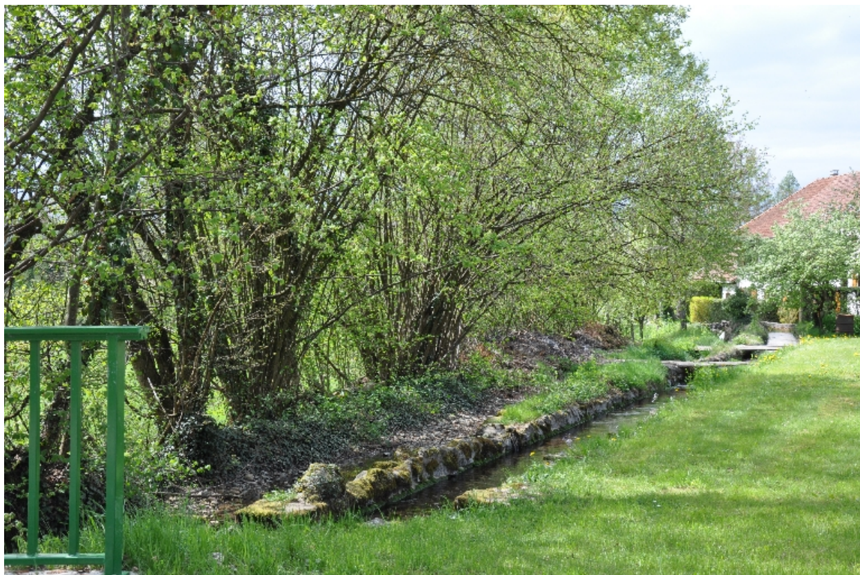
Vue du canal d'amenée de l'ancienne scierie
