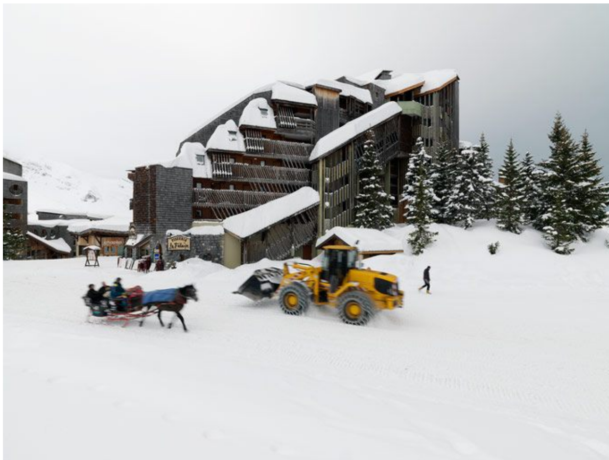
Vue sous la neige
