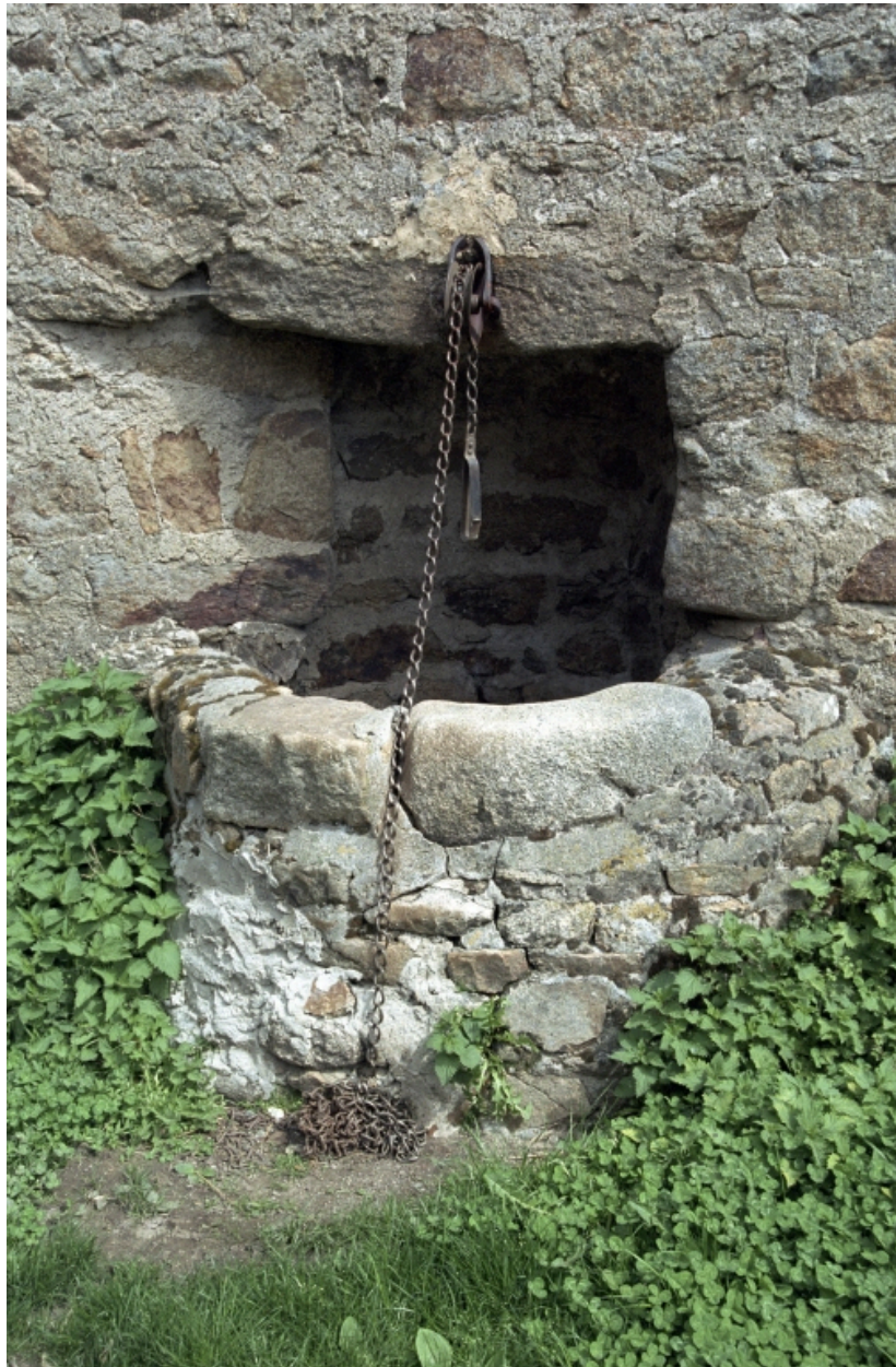
Exemple de puits adossé à un mur dans une ferme à Lard (1987 B2 753 à 756, 811).
