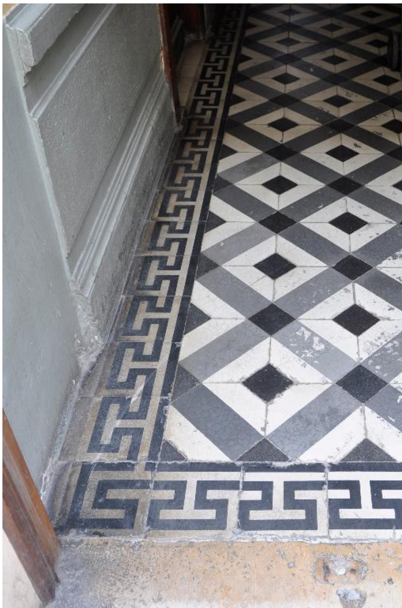
Vue intérieure : détail du pavement de l'allée
