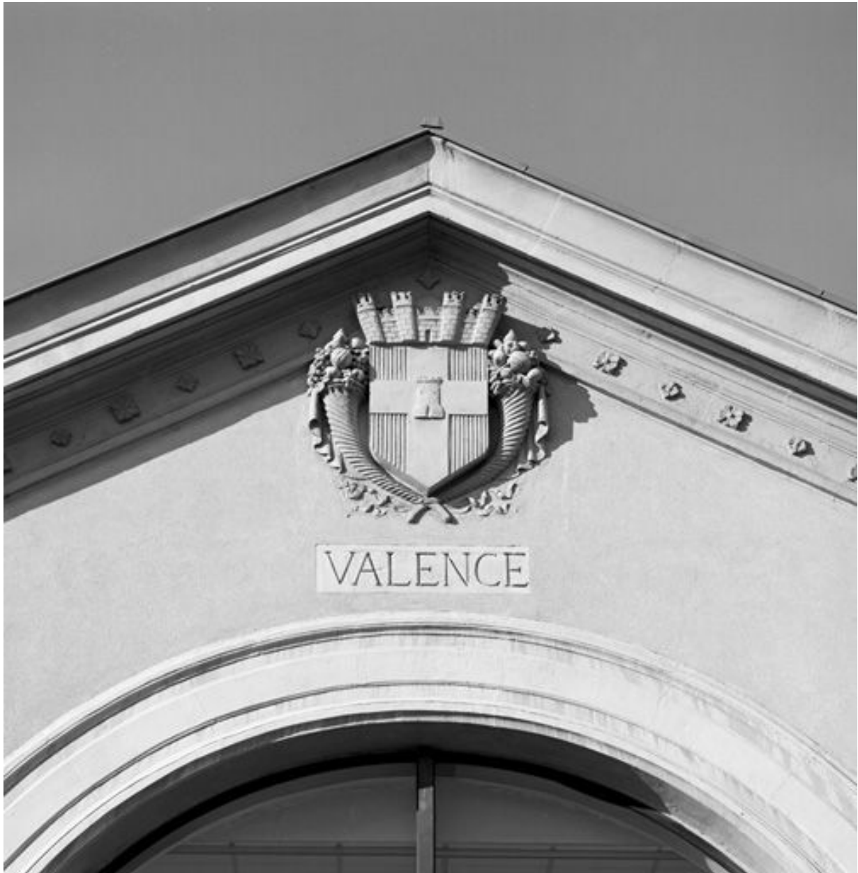
Le bâtiment-voyageurs : bâtiment latéral est, écusson aux armes de Valence
