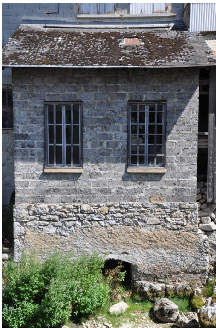
Détail du percement rectangulaire de la façade ouest
