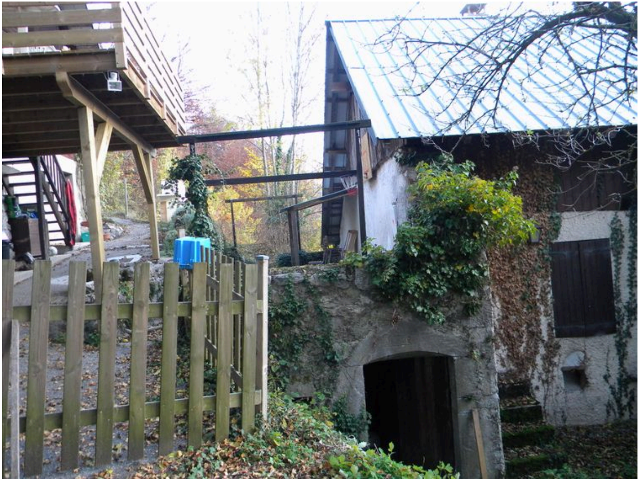
Vue de trois-quarts des façades nord-ouest et nord-est.
