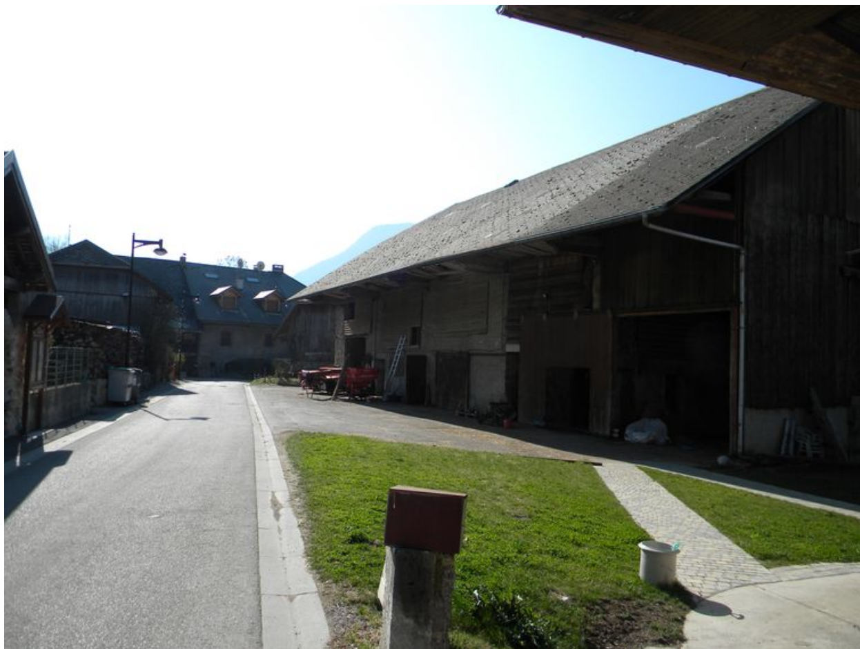
Façade d'une ferme en exploitation au coeur du hameau (A3 970, 973).
