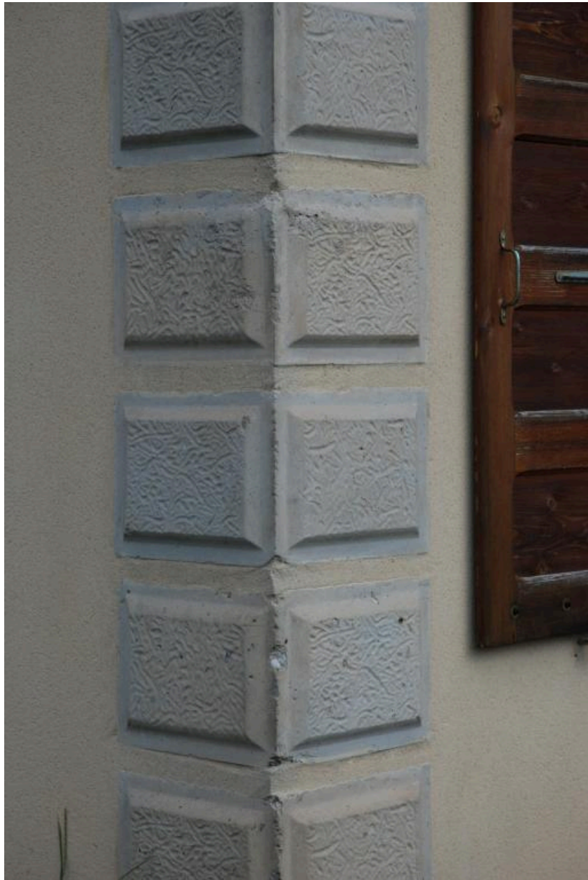
Angle en béton moulé à décor de bossage. Maison (2017 C4 288), non repérée.
