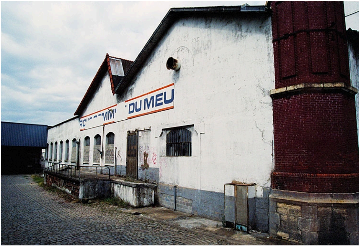
Vue du bâtiment des chaufferies
