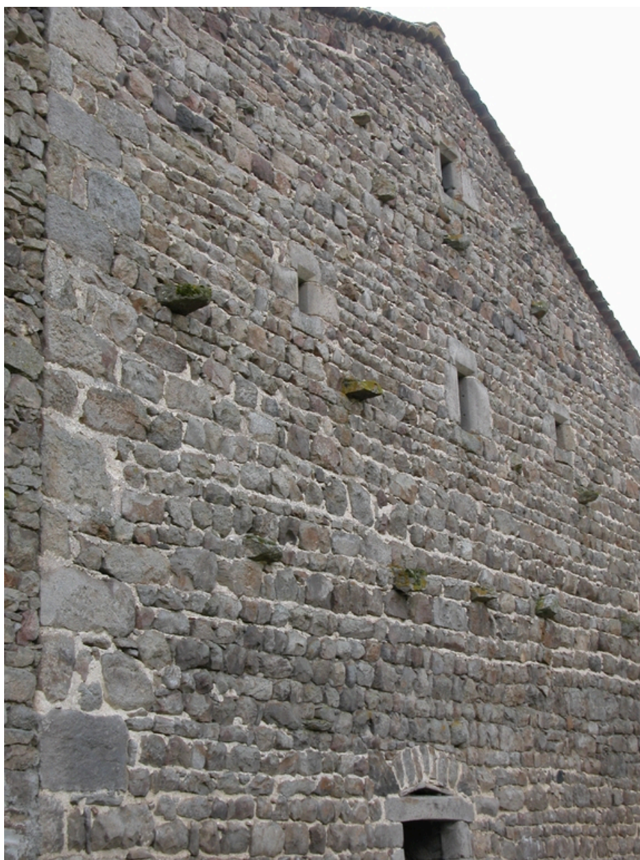
Vue du pignon de la grange-étable.
