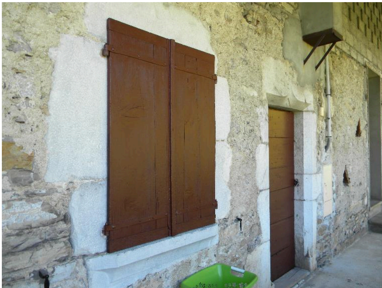
Vue des encadrements de la cuisine.
