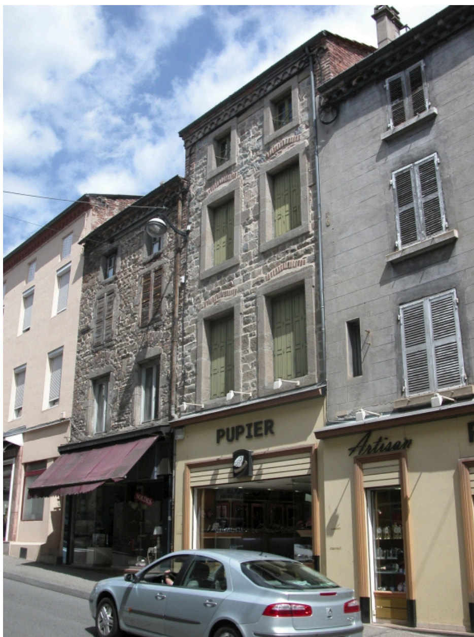
Îlot 2. Clermont (rue de) 61. Vue générale de la façade sur rue.
