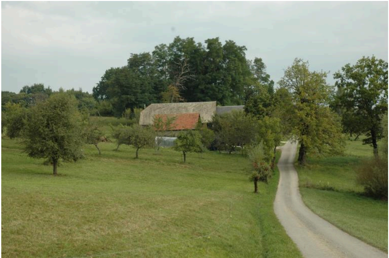
Vue générale depuis le sud.
