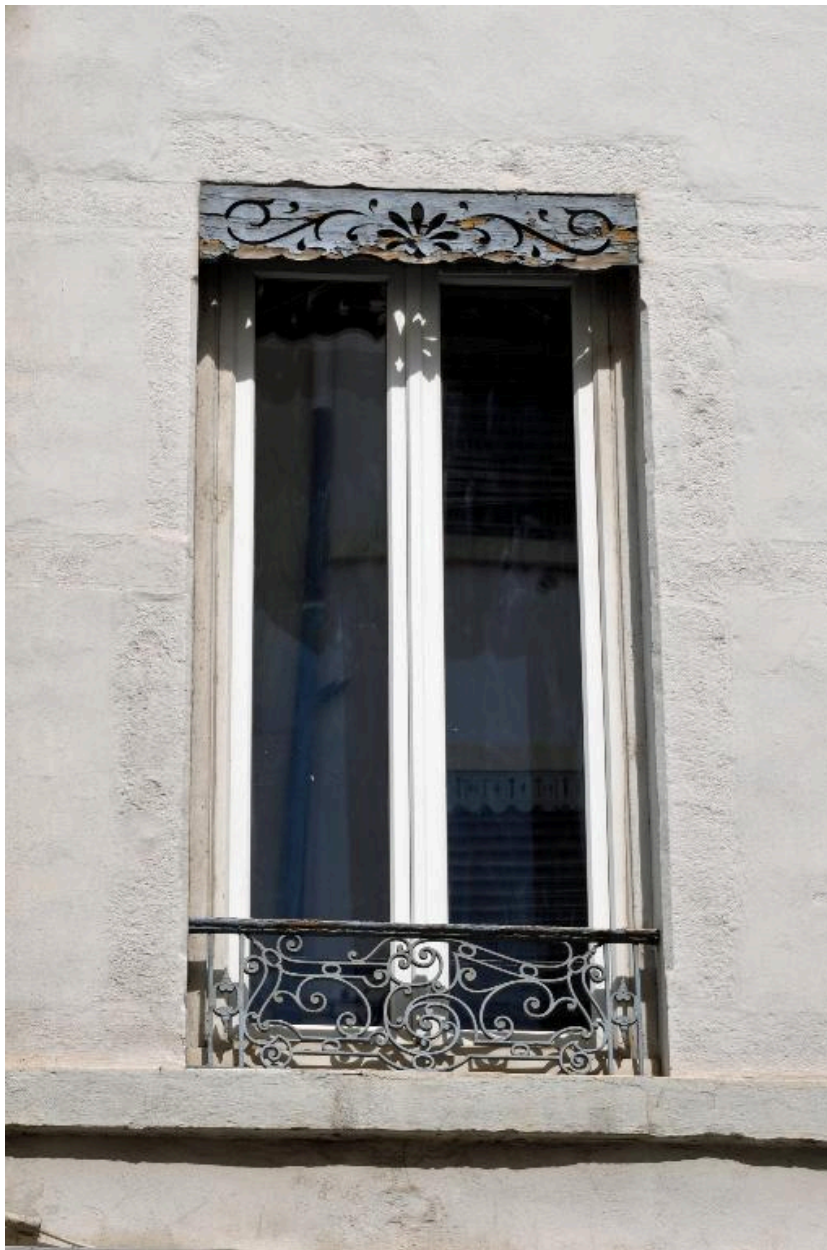
Détail d'une fenêtre du premier étage : garde-corps en ferronnerie et lambrequin en bois
