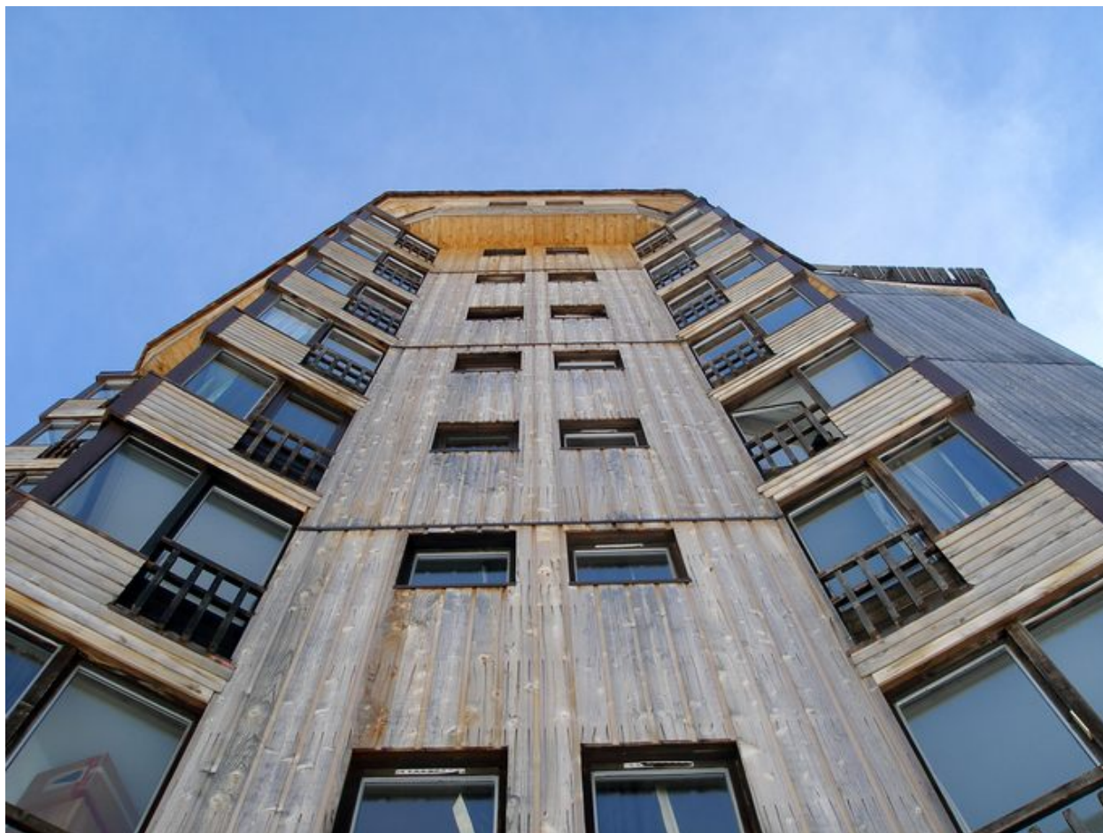
Détail de la façade nord
