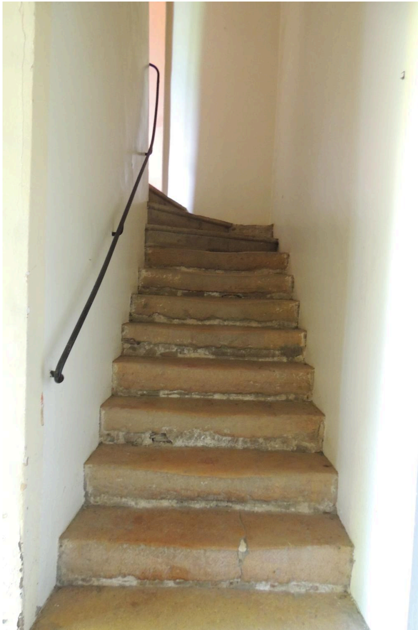
Escalier d'accès à l'étage.
