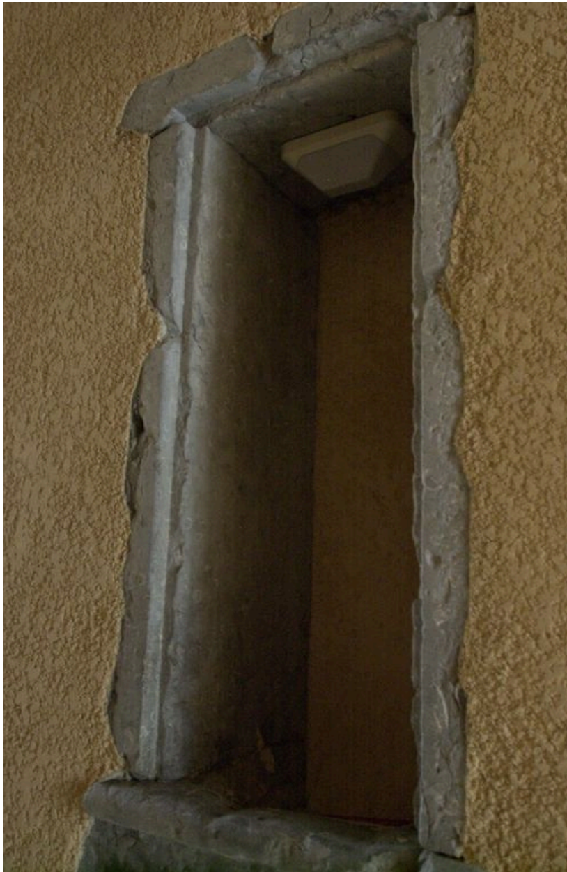
Vestibule, détail d'une niche dans le mur
