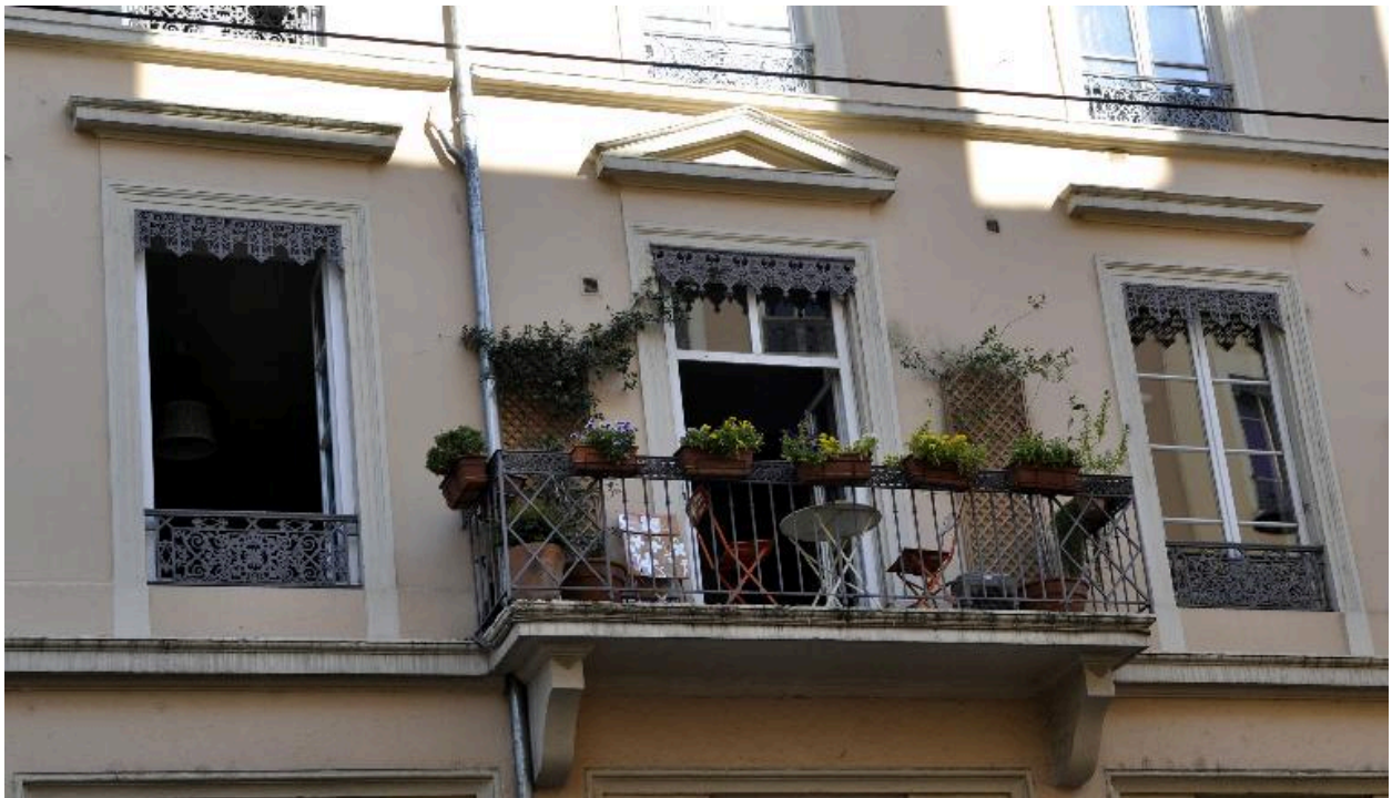
Immeuble sur rue, élévation antérieure : vue du premier étage avec son balcon central
