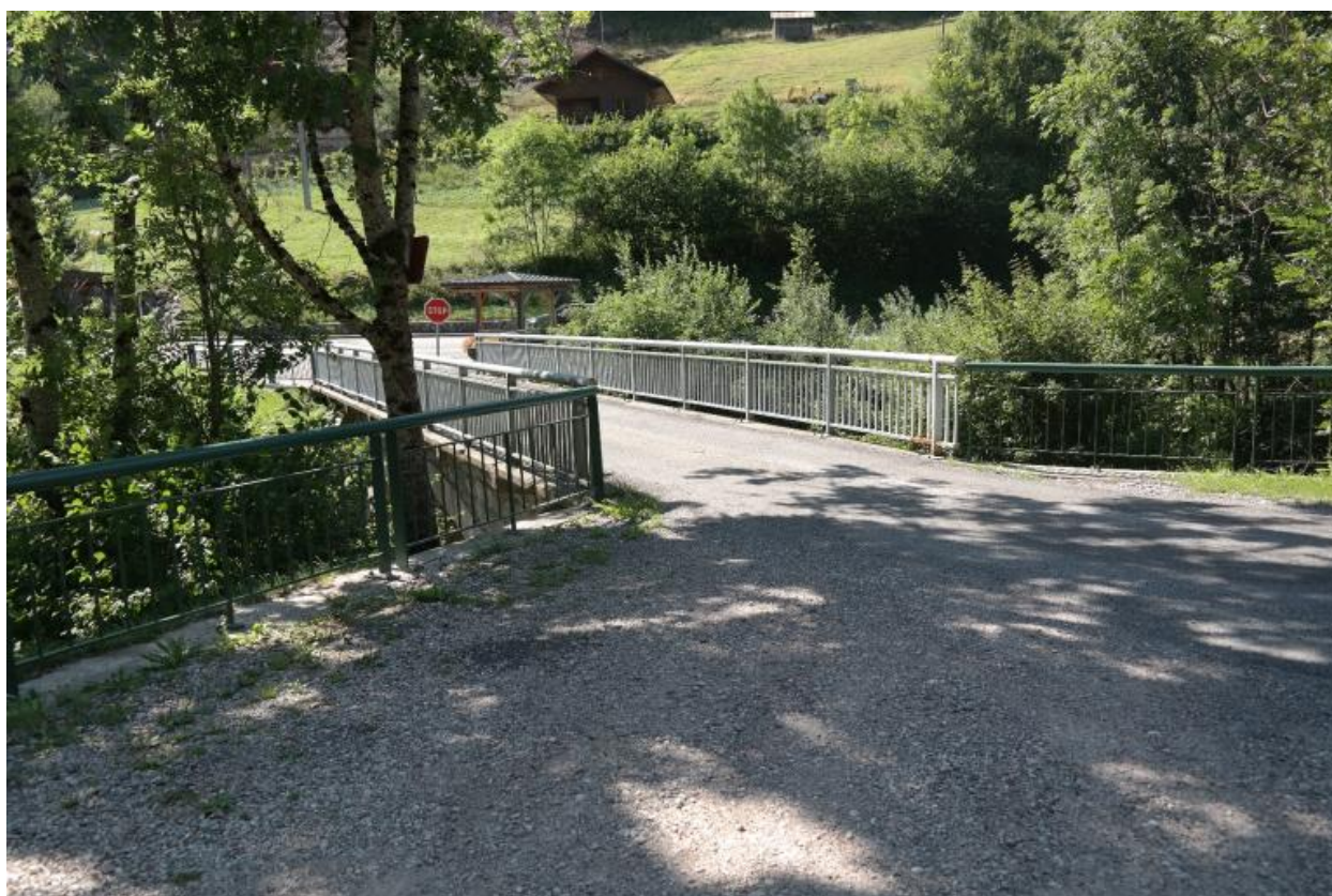
Vue générale du pont de Centfontaine
