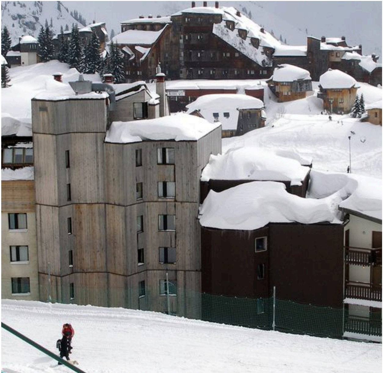
Façade amont. Vue depuis le nord
