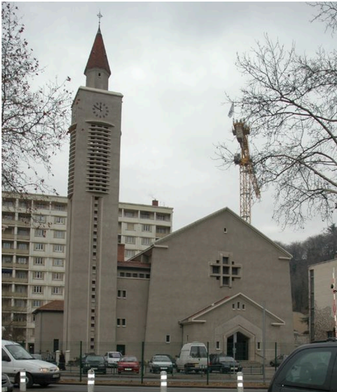
Vue générale depuis le sud
