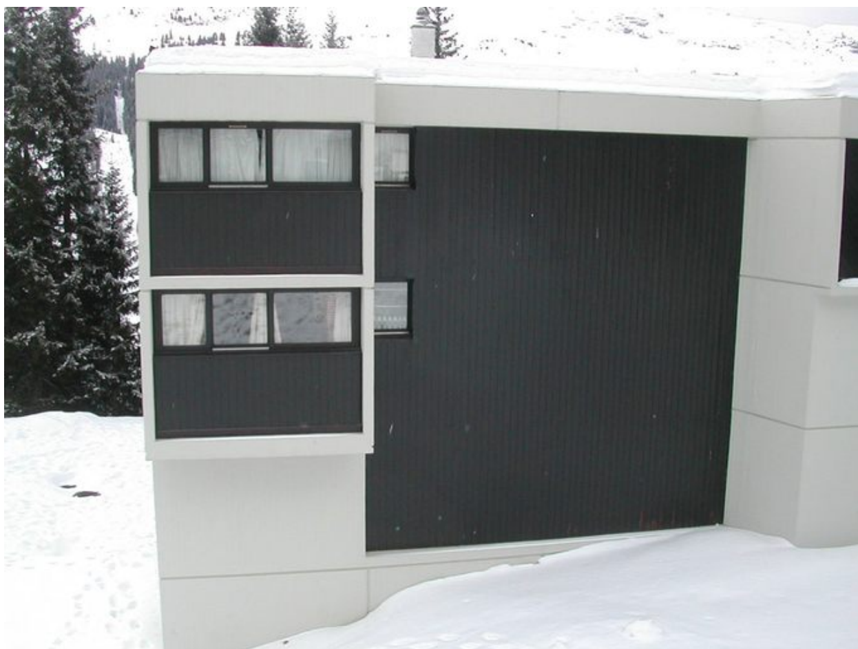
Elévation principale, partie est
