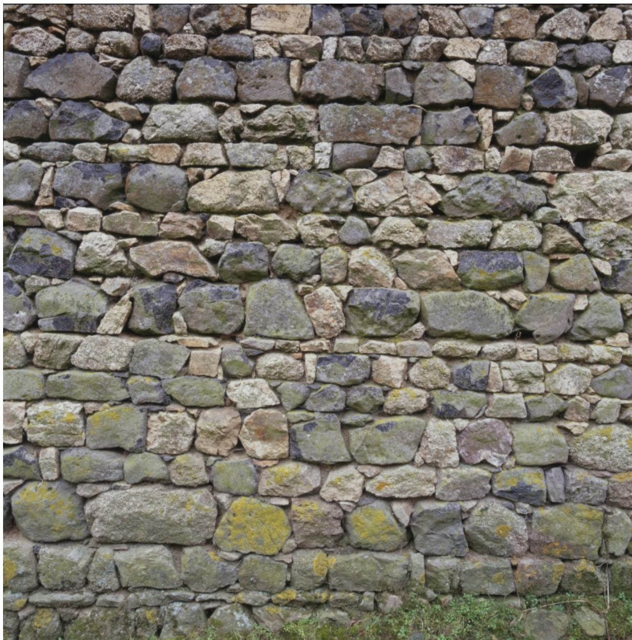
Détail du mur pignon du logis, partie nord.
