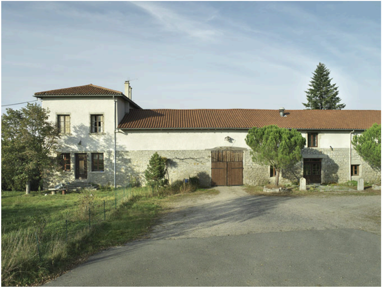
Vue de l'élévation sud, partie ouest.
