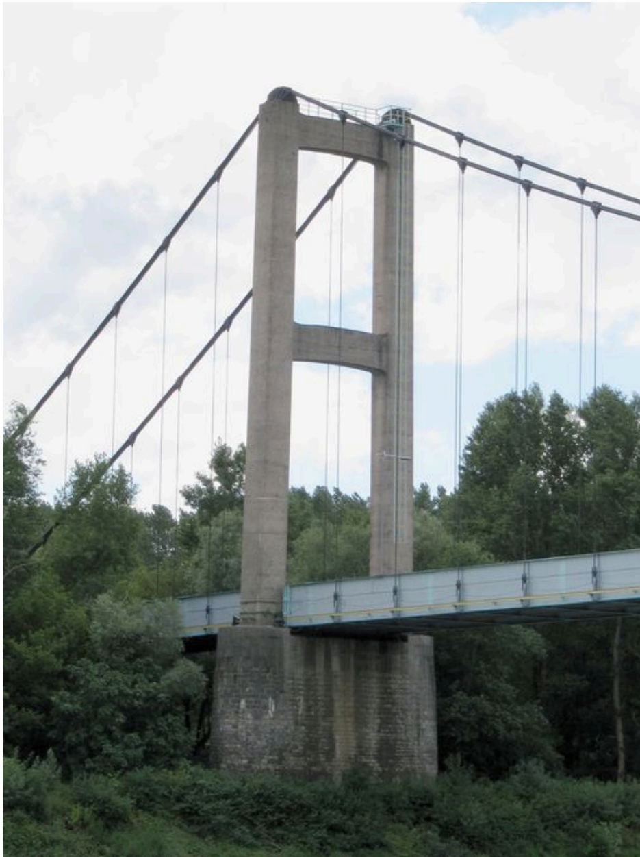
Pylône gauche, face amont, vue générale (depuis la rive droite)
