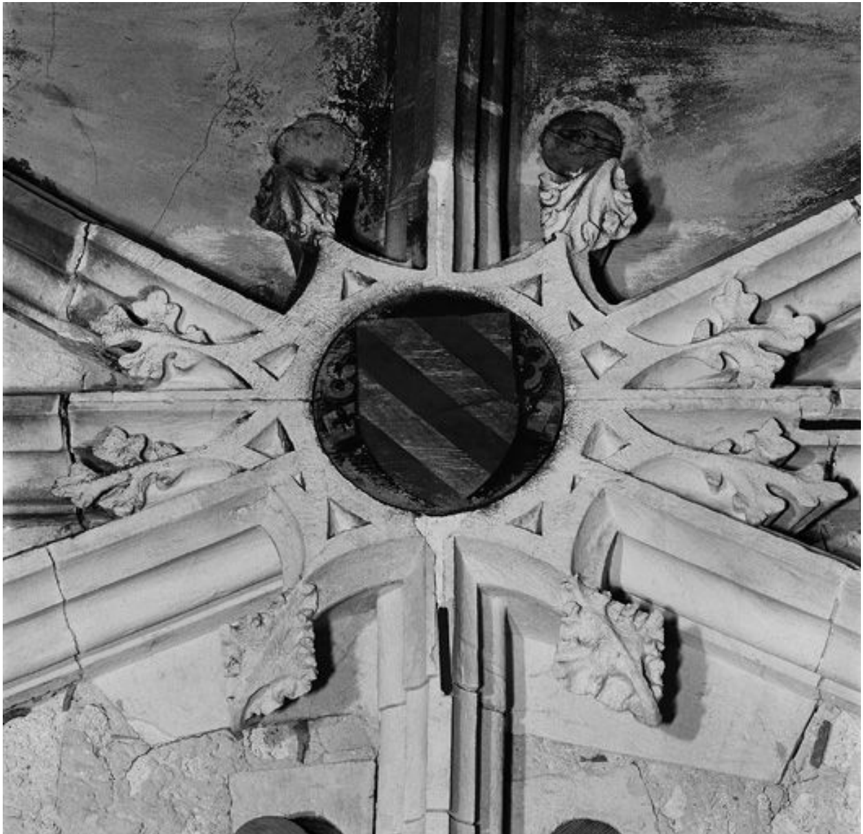
Voûte du vaisseau central en cours de restauration en 1977, travée VI, détail de la clef de voûte principale aux armes de l'archevêque de Lyon Henri II de Villars
