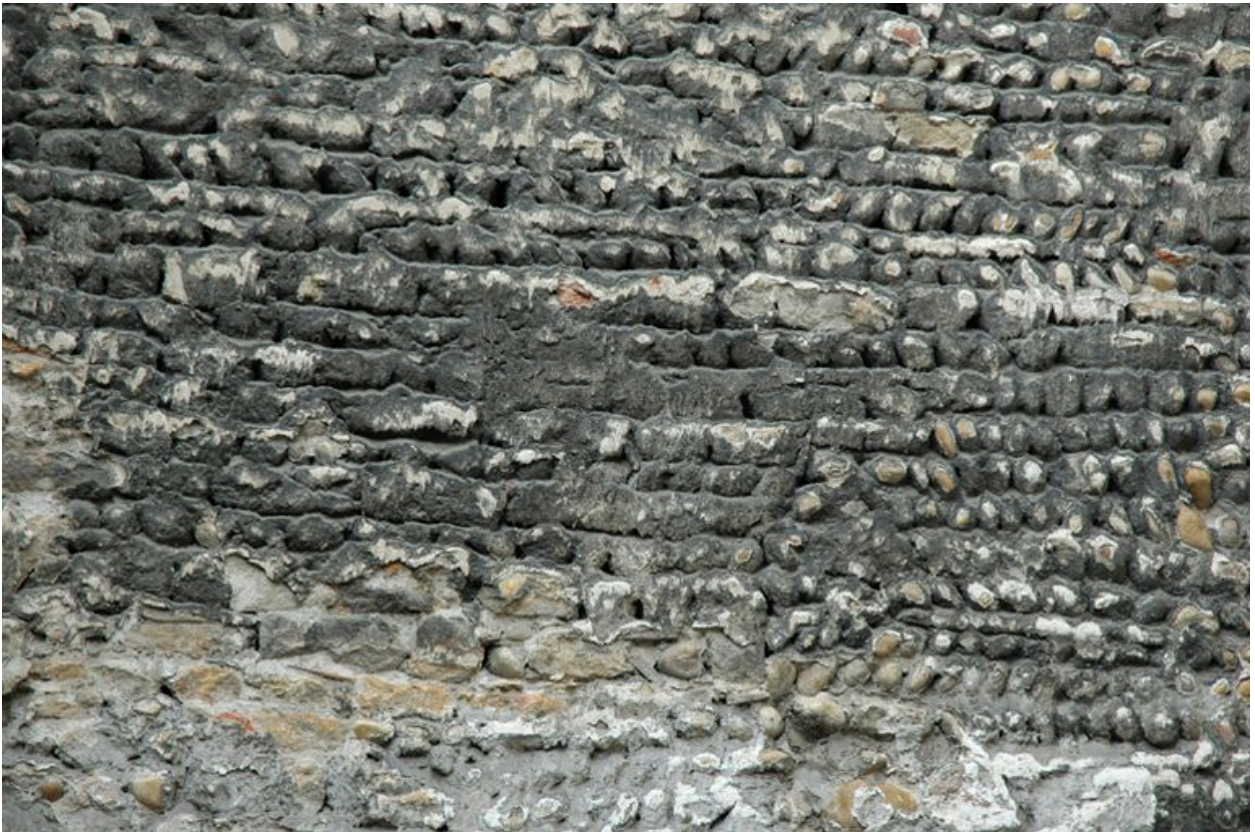
Détail de l'appareillage en arêtes de poisson du mur ouest
