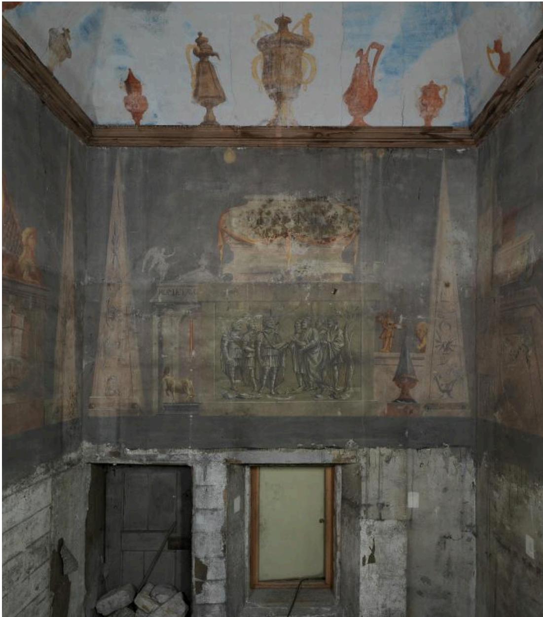
Mur est : vue d'ensemble après dépose des boiseries, sept. 2018
