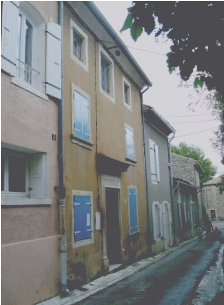
Le Pègue, Grand'rue. Maison (B3 685), façade sur la Grand'rue.
