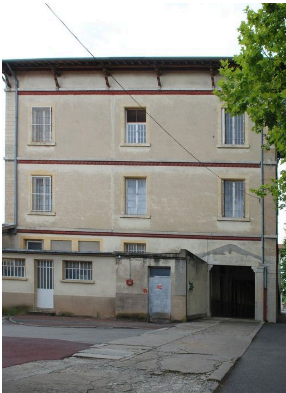
Façade latérale nord
