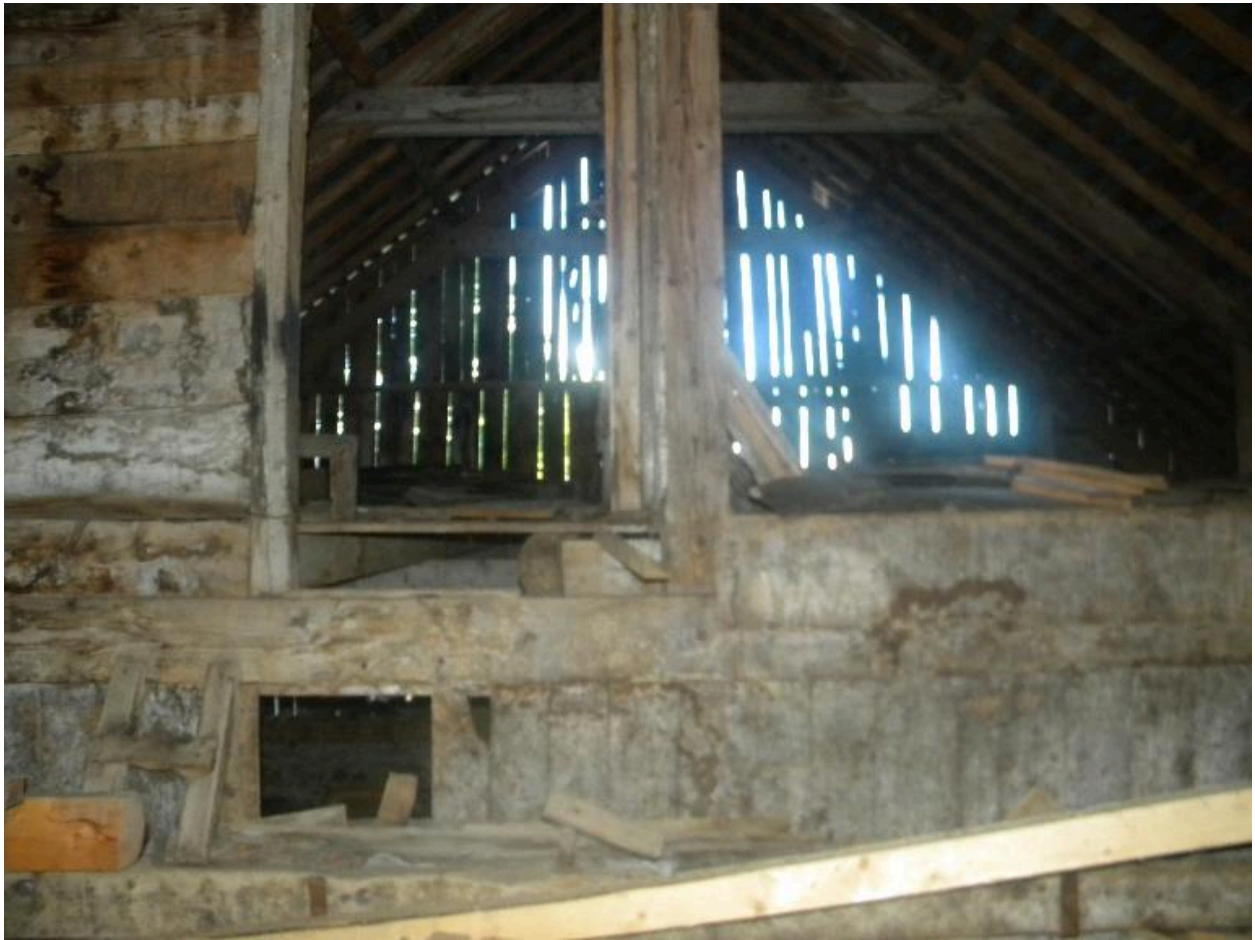
Détail de la charpente et des ouverture pour passer le foin dans l'étable.
