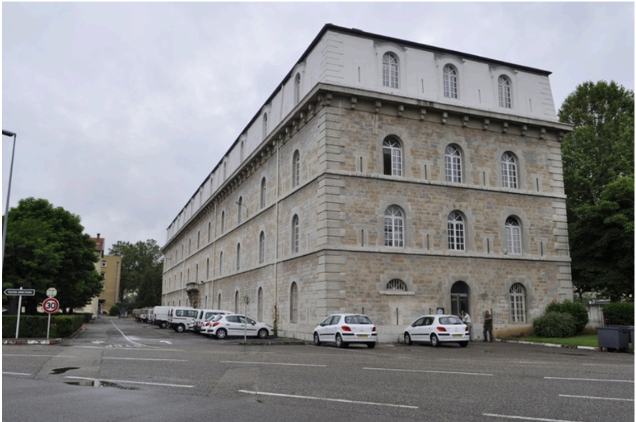
Vue du bâtiment principal, pignon est.
