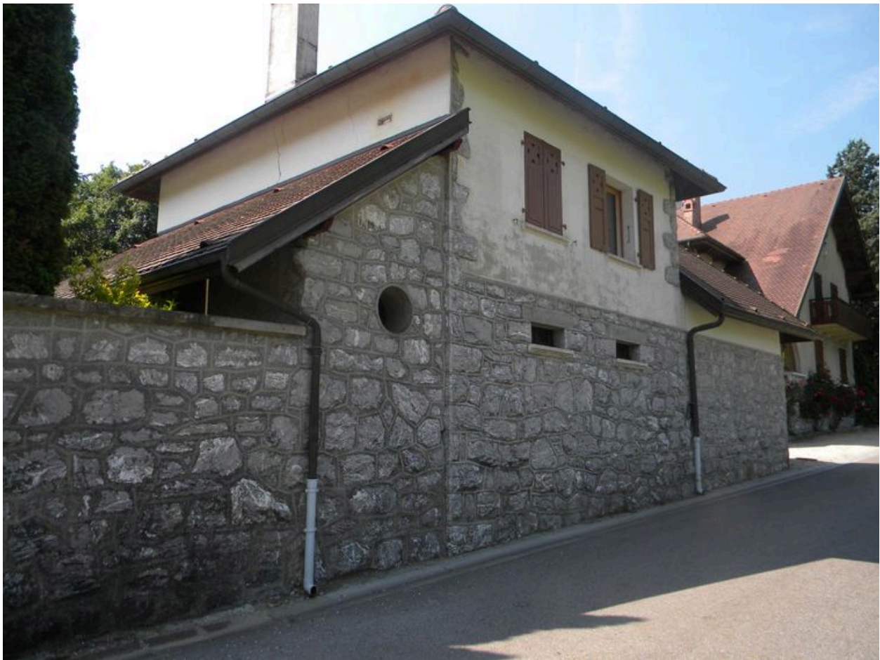
Vue avale de la dépendance d'une maison bourgeoise près de Loche (2008 A2 1223).
