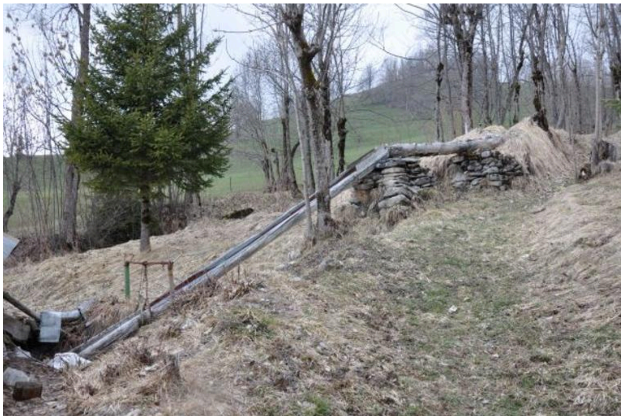
Arrivée de la dérivation au niveau du moulin aval.
